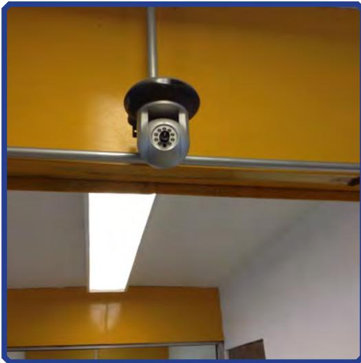
Foto 4.3. Cámara de seguridad al interior de la CUAS Aurora.
