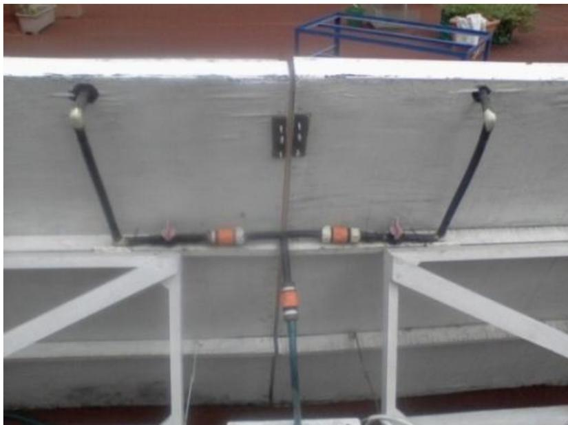
Figura 23. (a) Vista de la conexión en "Y" para el suministro del agua de riego a ambos paneles.
