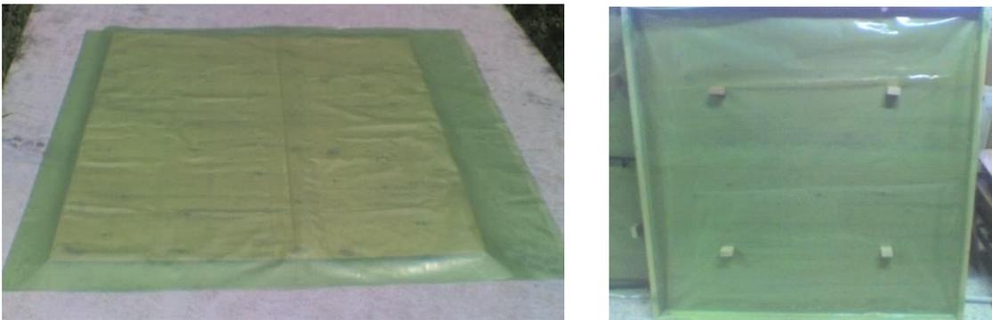
Figura 2. (a) Colocación de la primera capa de hule para impermeabilizar ambos paneles. (b) Bastidor con la segunda capa de hule y con soportes para el anclaje de la malla de contención.
