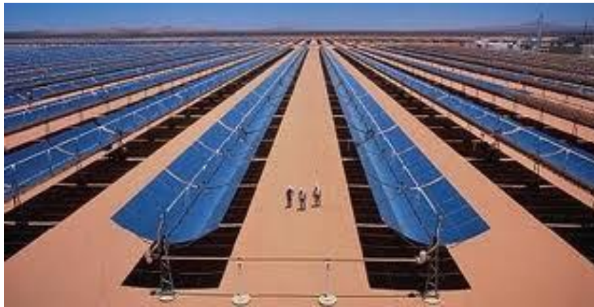
IMAGEN 8. PARQUE SOLAR AGUA PRIETA II, SONORA
