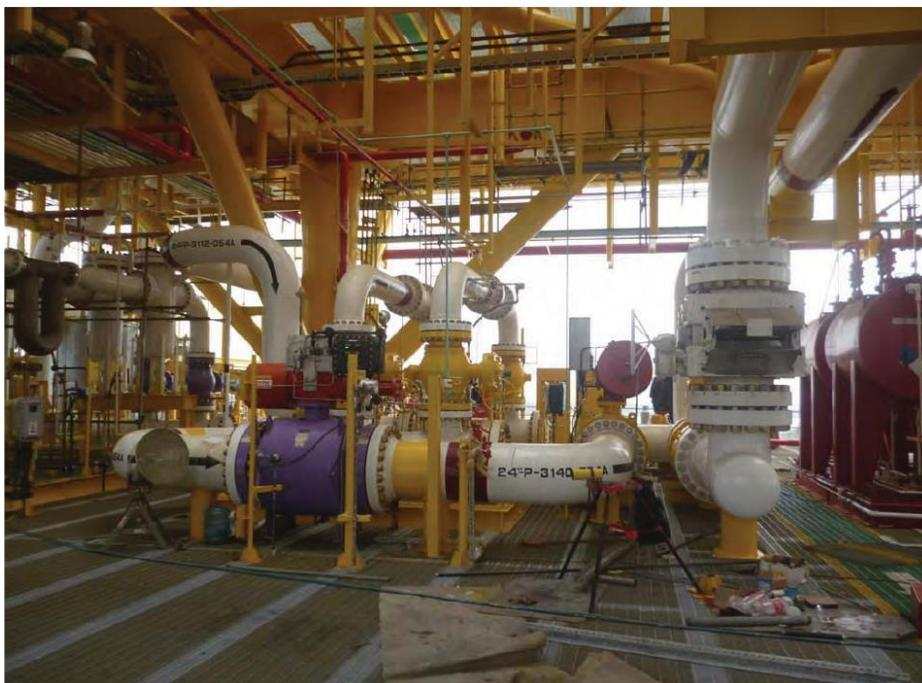
Fig. 6.6 a. Sistema de medición instalado
