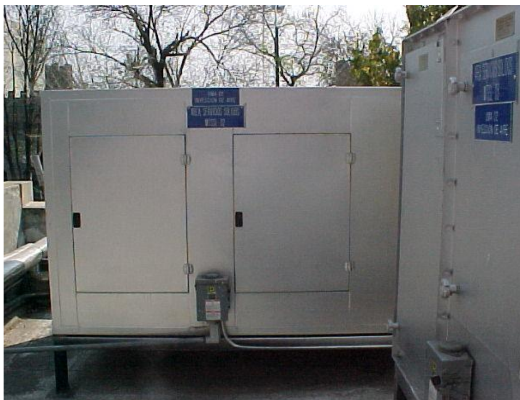
Fig.1 Unidad Manejadora de Aire de Sólidos Orales.
