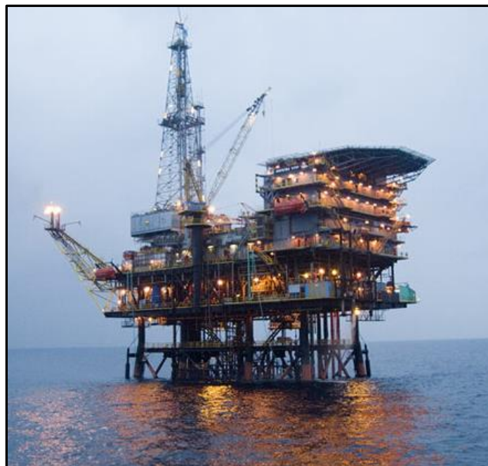
Figura 2-11 Plataforma de perforación. ( http://noticiasmontreal.com )
