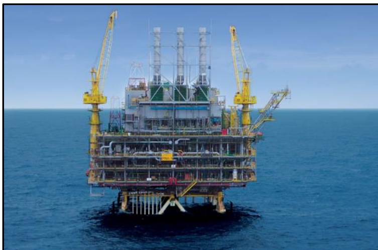
Figura 2-13 Plataforma de rebomdeo. ( http://www.hotsitespetrobras.com.br )
