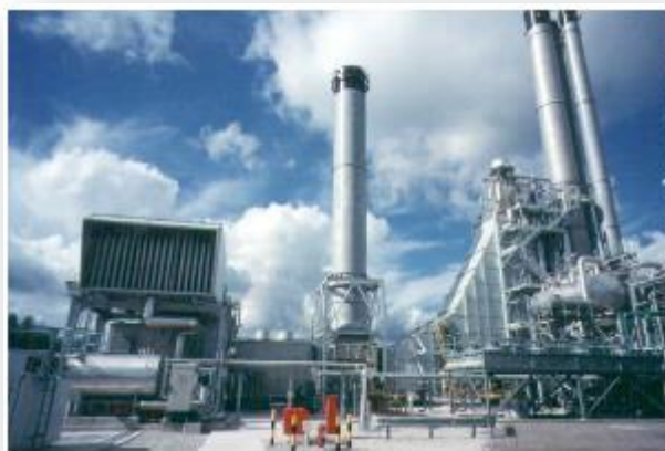
Figura 2.13 Instalación de planta de generación de energía eléctrica con tecnología de turbina de gas. Fuente: CRE.
