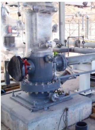
Colocación bomba de gas LPG
