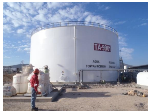
Tanque de agua contra incendio
