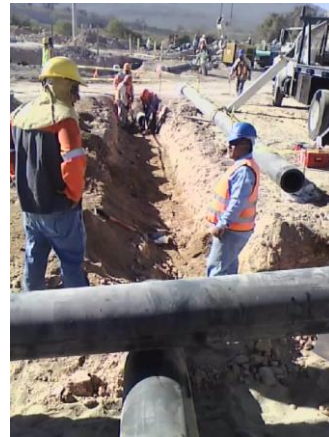
Colocación tubería PEAD
