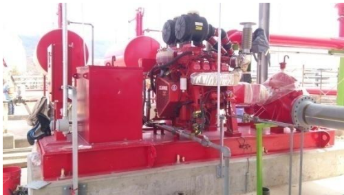
Bombas de agua contraincendios
