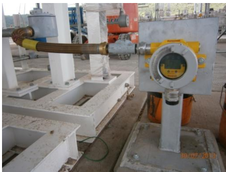
Instalación de detectores de humo
