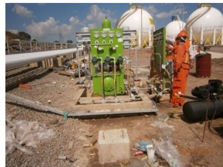
Instalación unidad hidráulica
