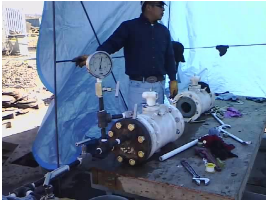
Prueba hidrostática de válvulas
