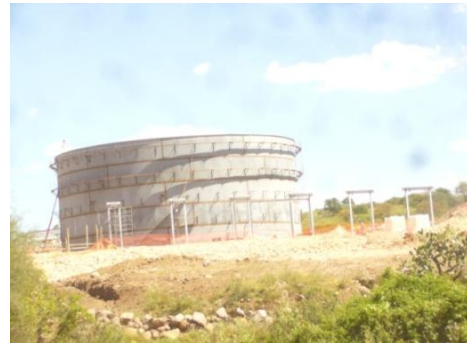
Armado de tanque CI
