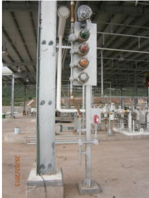
Instalación de semáforos G&F
