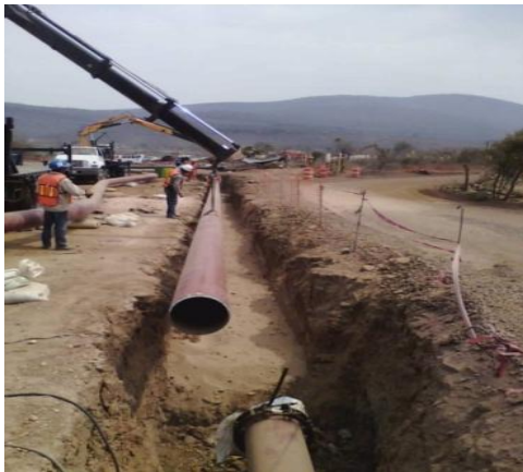
Colocación tubería de interconexión
