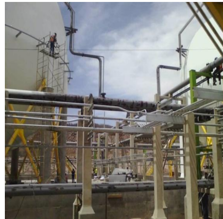
Montaje de tubería contra incendio
