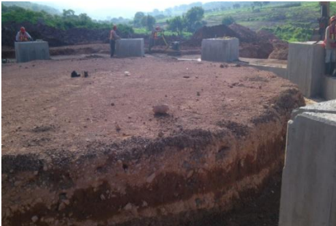
Cimentación esferas de almacenamiento
