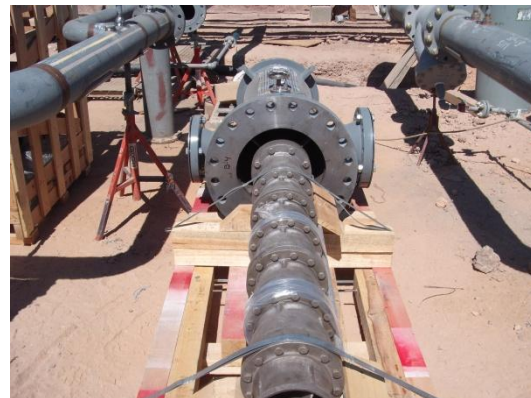
Bomba de gas LPG
