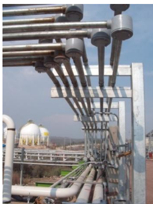
Colocación tubería conduit
