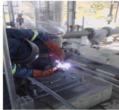
Soldadura de tubería
