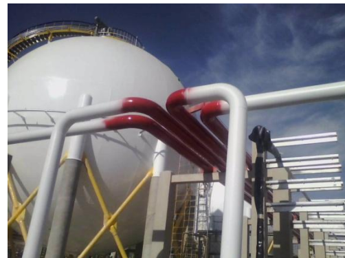
Aplicación de acabado
