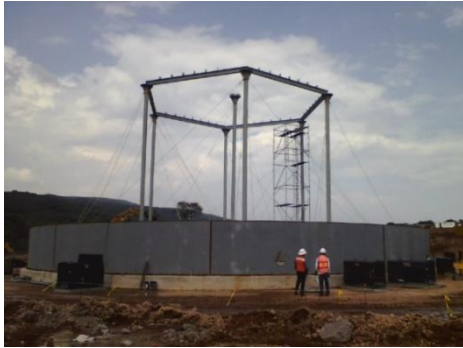
Elementos estructurales tanques CI
