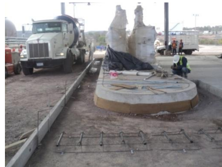
Cimentación skid de carga
