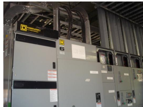
Llegada eléctrica a CCM
