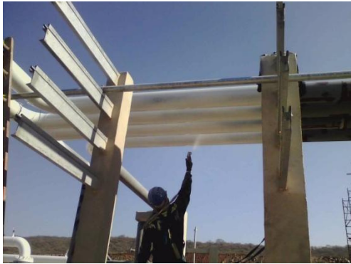
Aplicación de recubrimiento a tubería
