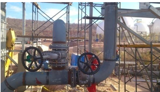
Colocación de válvulas
