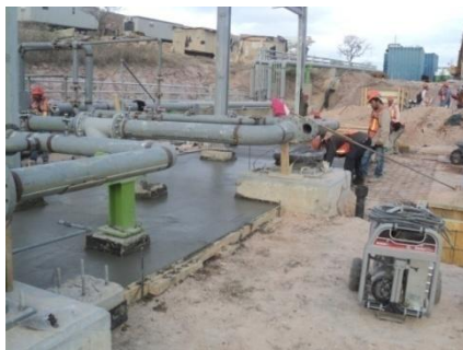
Cimentación en casa de bombas de proceso
