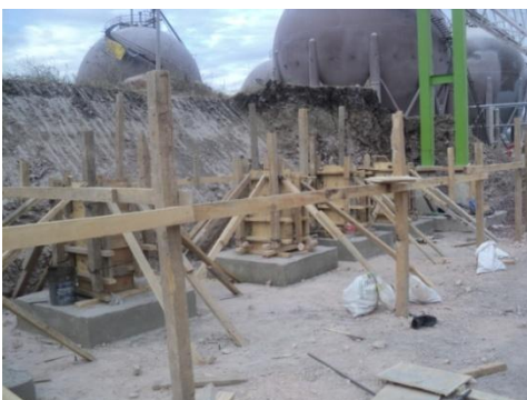
Cimbra para soporte de tuberías
