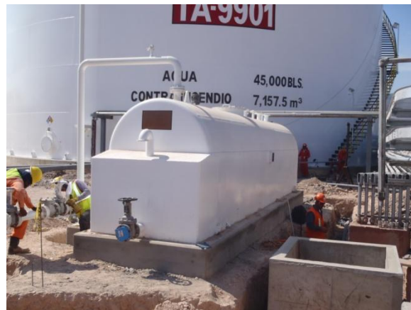
Tanque de almacenamiento de diesel
