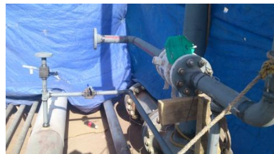
Prueba hidrostática en línea de tubería
