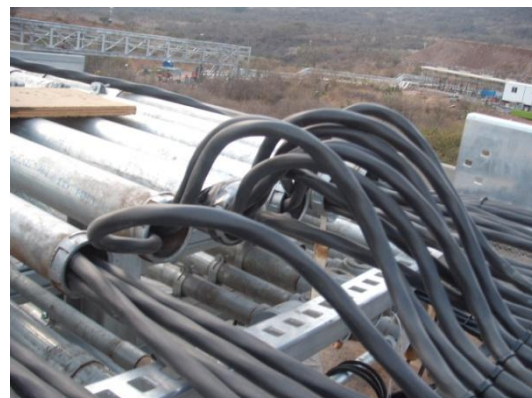
Cableado para planta
