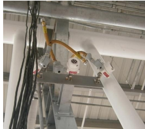
Instalación de detectores de humo
