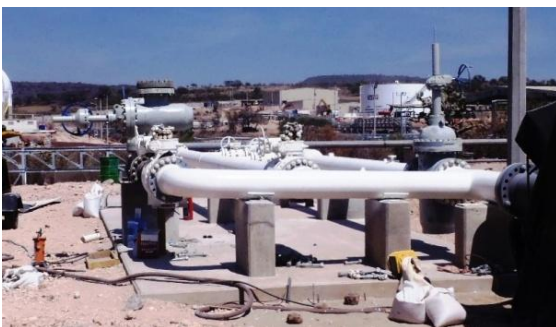
Colocación de trampa de diablos
