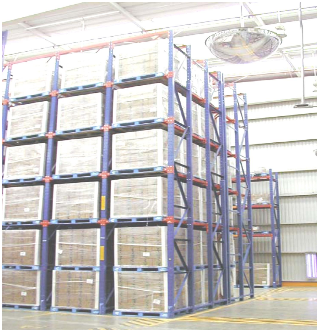
Figura no. 15 Racks de almacenamiento
