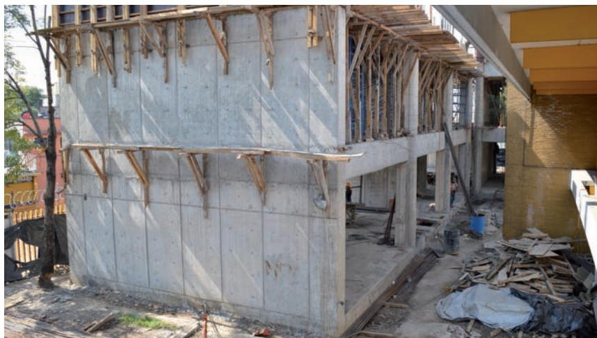
Construcción de aulas para Psicología
