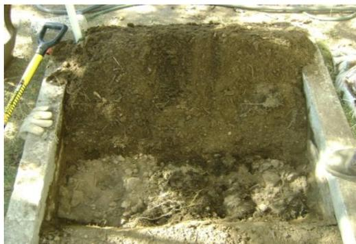
**Figura 4. Excavación de la segunda zanja de 30 x 30 cm.**
