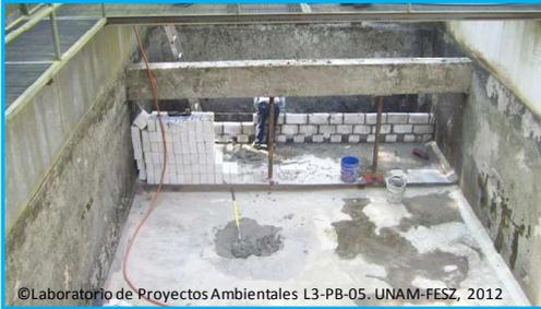
Se rehabilitó la planta de tratamiento inoperante, con la finalidad de implementar un humedal de flujo subsuperficial. En las imágenes superiores se aprecia la construcción de una barda con el objetivo de distribuir el flujo del agua de manera uniforme y finalmente en la imagen inferior derecha se muestra el momento en el que se rellena con sustrato.
