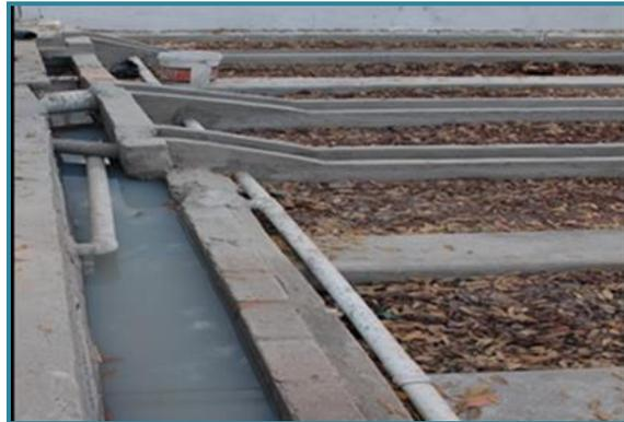
**FOTO 15 Y 16. CAMBIO DE TUBERÍA DE ALIMENTACIÓN.**
