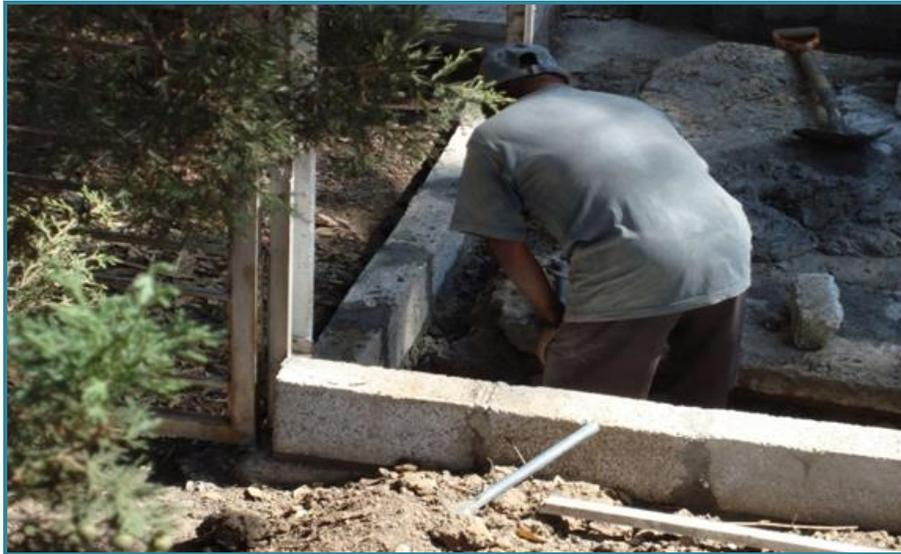
**FOTO 14. ELEVACIÓN DE PAREDES DE CONTENCIÓN**
