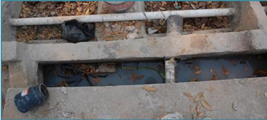
**FOTO 11. CAMBIÓ DE TUBERÍA DE ENTRADA DE AGUAS NEGRAS A DEPÓSITO DE ENTRADA PARA MEJORAR EL FLUJO DE ESTAS DENTRO DEL SISTEMA**
