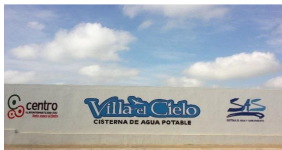
Figura 48. Cisterna de agua potable. “El Cielo”, Tabasco.
