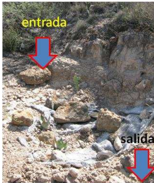
Figura. 12 Diques en la cárcava donde se muestra la entrada y la salida.
