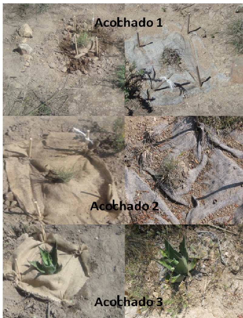
Fig. 26 Acolchados en la ZA, con retención de materiales disgregados y la presencia de algunas plantas acompañantes.
