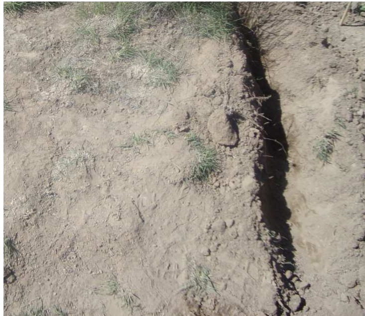
Figura. 10 Elaboración de la Zanja
