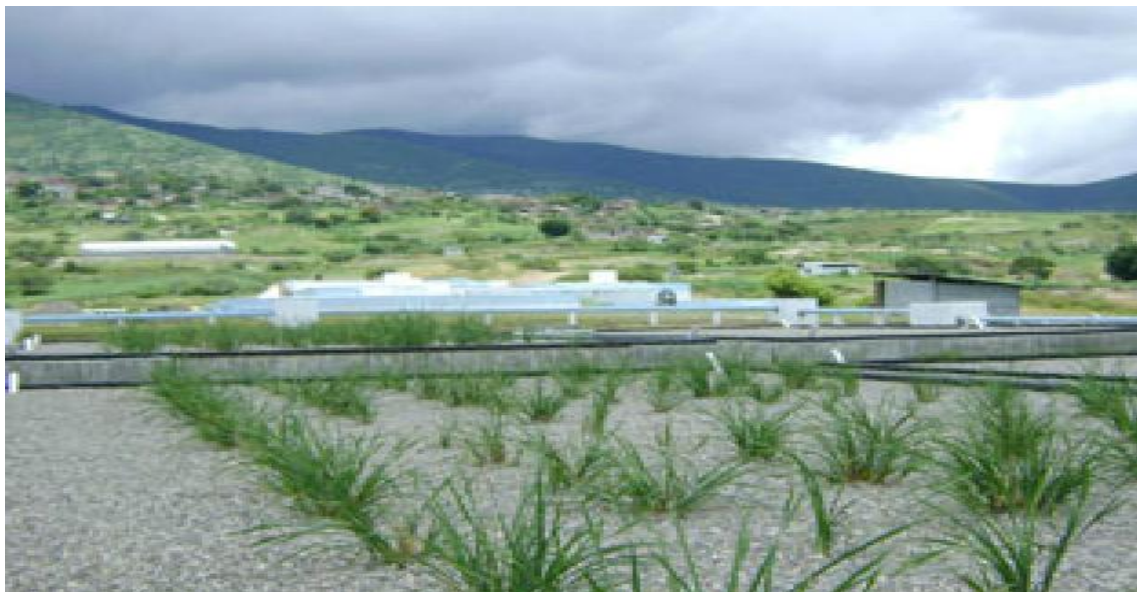
Figura 10. Humedal artificial para el tratamiento de aguas residuales domésticas. Tomado de Estadísticas del Agua en México, CONAGUA, 2010
