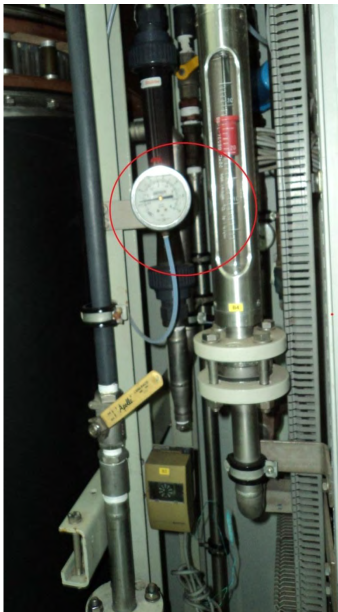
b) Fig. 2.13 Manómetro para el generador de ozono
