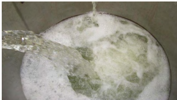
Fig. 2.20 Tanque de Ozonación visto por dentro.
