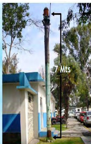
Pozo que demuestra el hundimiento en San Juan de Aragón en el periodo 1936-2005.
