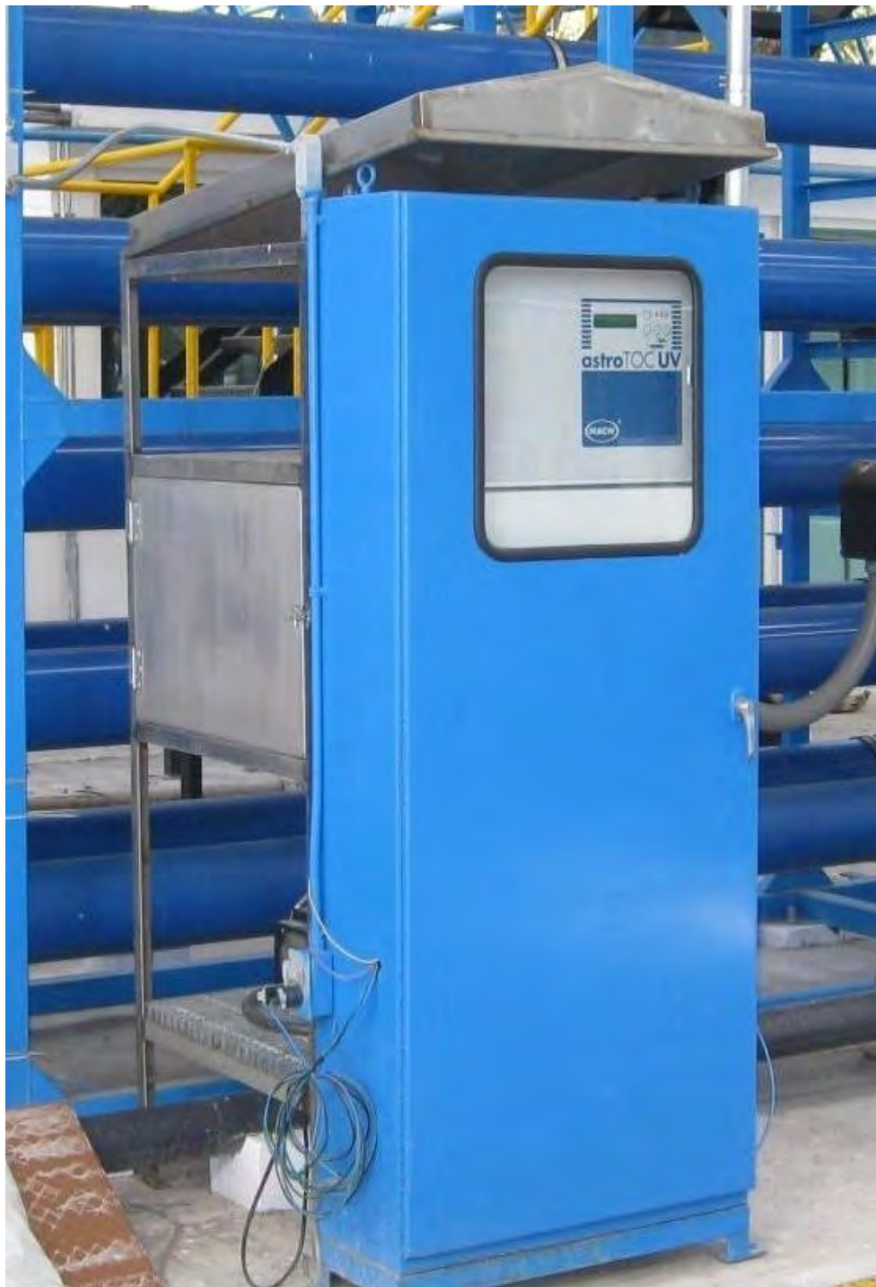
Fig. 2.27 Medidor de COT en línea
