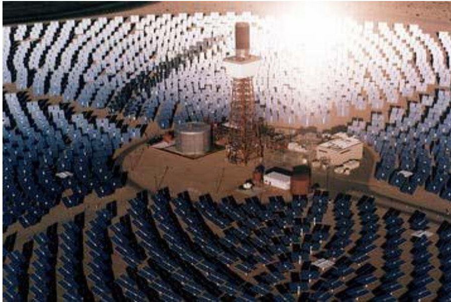
Figura 2.e Sistema de Torre Central “Gemasolar” en España
