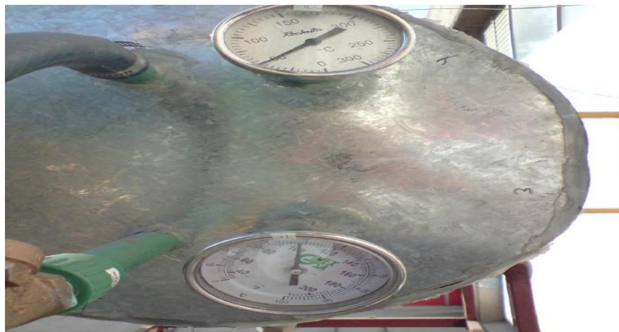
Figura 3.g Instalación del tanque de almacenamiento.
