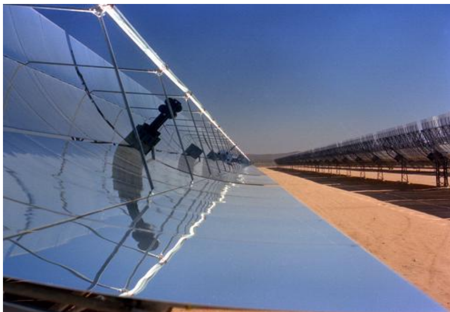
Figura 2.d El concentrador tipo canal parabólico solo aprovecha la radiación directa del sol.
