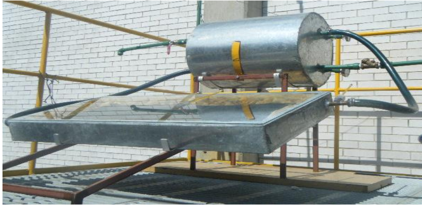
Figura 3.h Instalación completa del calentador.
