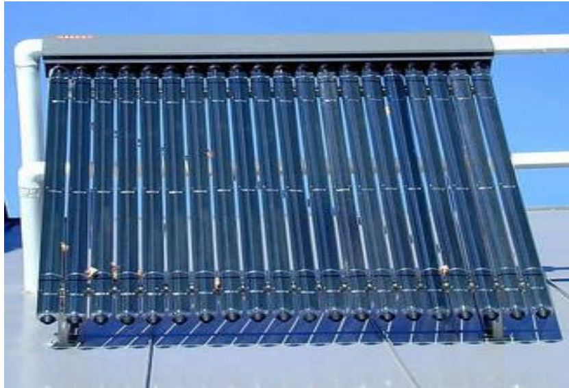
Figura 2.c Calentador con Tubos de Vacío.
