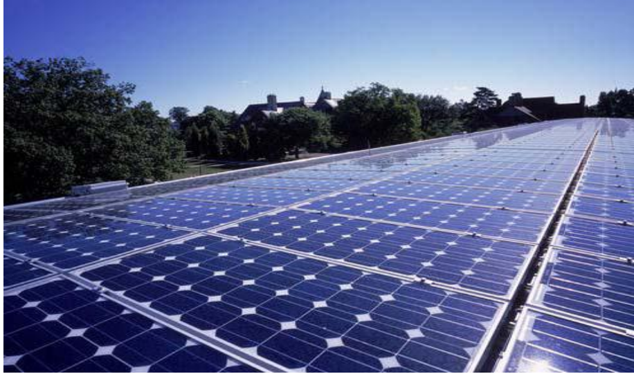
Figura 1.a Conjunto de paneles fotovoltaicos.
