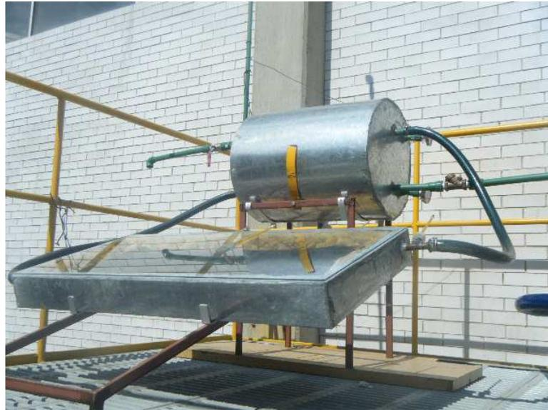
Figura 3.3 Sistema colector instalado en FES Zaragoza Campo II
