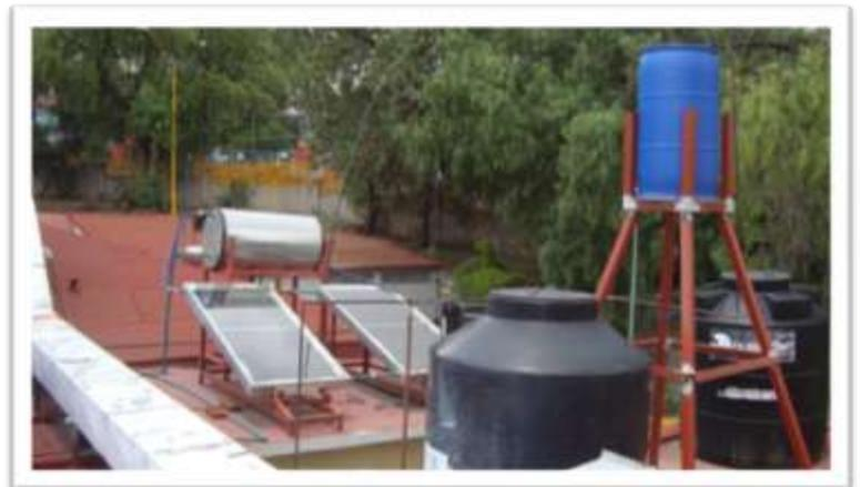
Figura 4.7.8 Vista con todos los elementos que conforman al calentador solar
