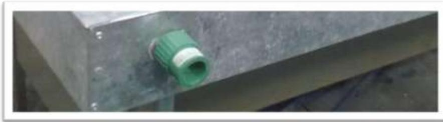
Figura 4.2.7 Orificio de 3/4" con conector de polipropileno
