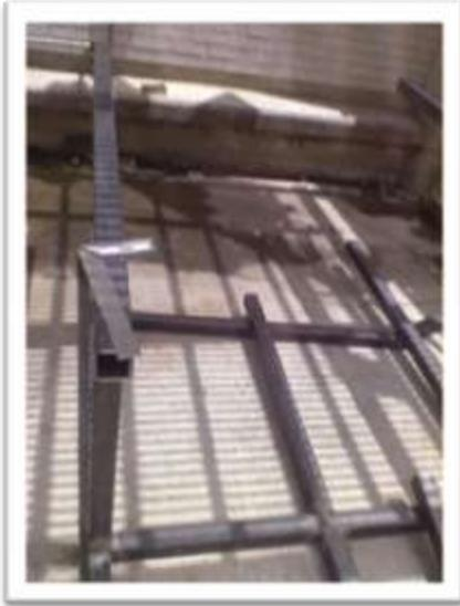
Figura 4.5.6 Unión de piezas para la base del termotanque
