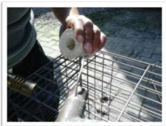
Figura 4.1.12 Soldadura derretida e impregnada por capilaridad
