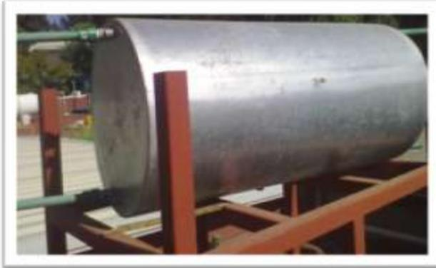
Figura 4.6.2 Termotanque con salidas laterales
