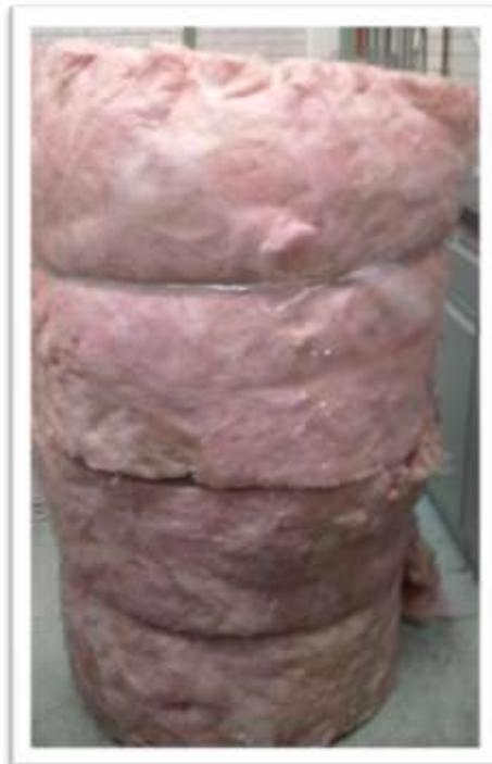
Figura 4.6.5 Termotanque cubierto con fibra de vidrio
