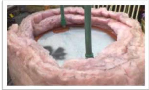
Figura 4.6.4 Termotanque aislado con fibra de vidrio
