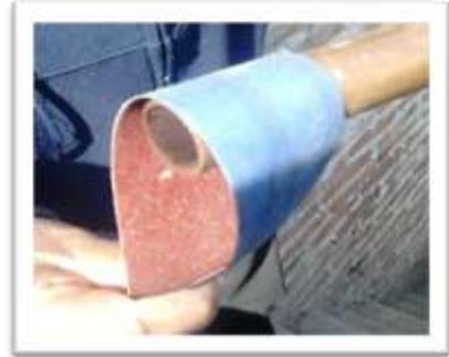
Figura 4.1.5 Lijado de tubos por extremos
