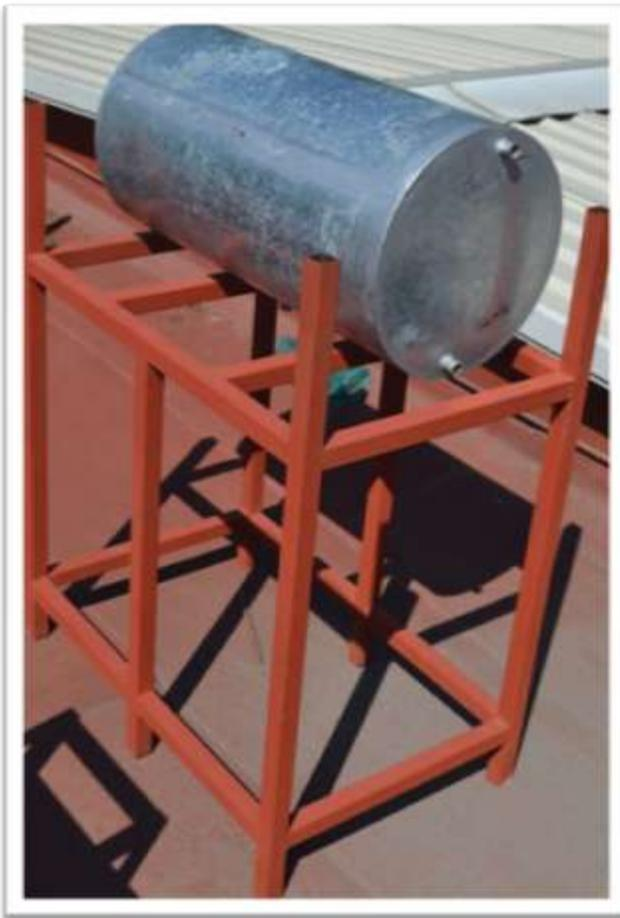
Figura 4.6.3 Termotanque con salidas laterales
