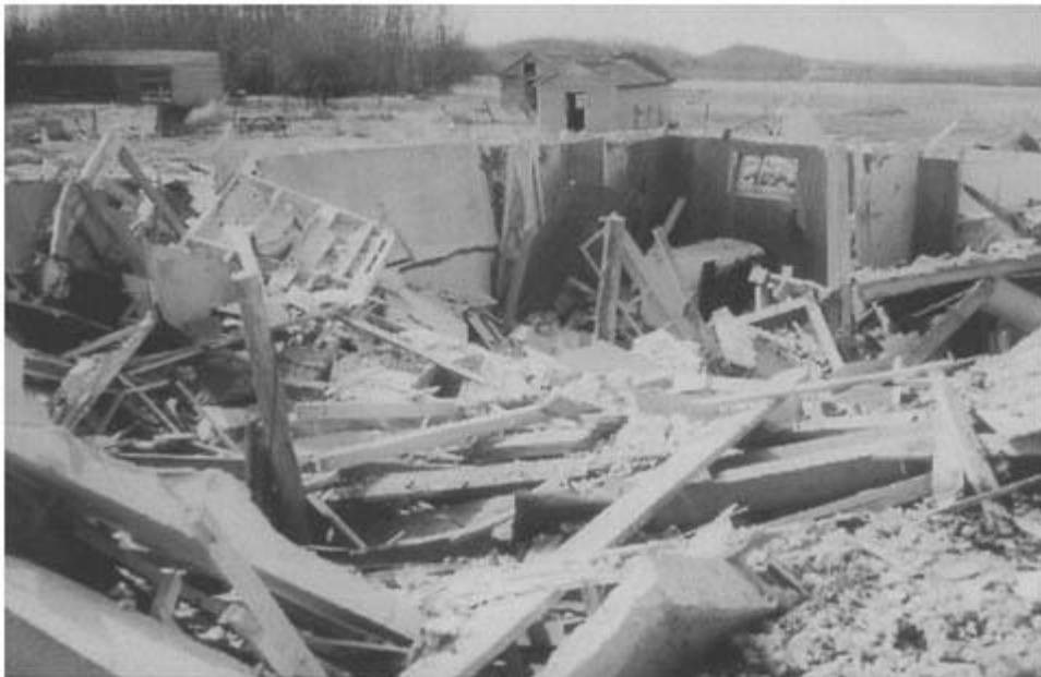
Figura 10. Secuelas de una explosión por gas natural
