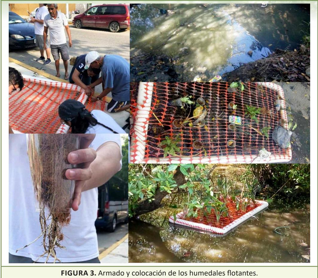
**FIGURA 3.** Armado y colocación de los humedales flotantes.
