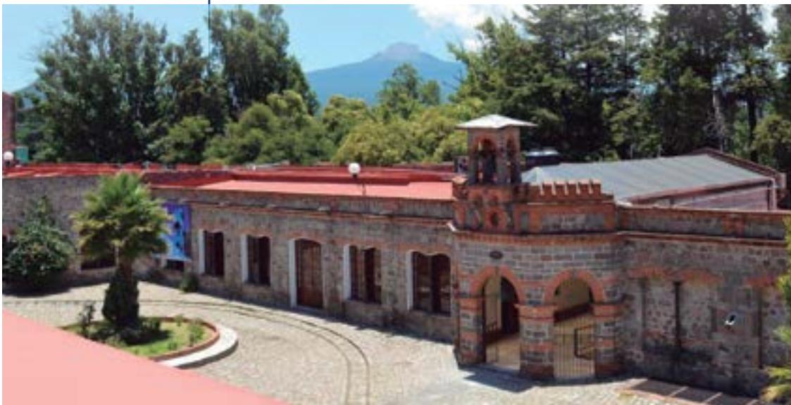
La fachada principal de la ex fábrica es de aparente aplanado, los muros son de piedra con un espesor de 60 centímetros
