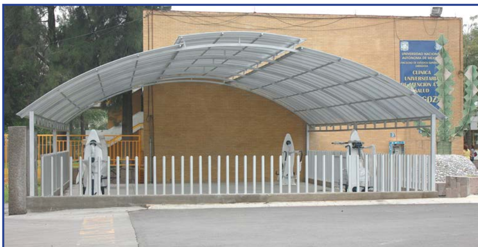
FOTO 31. Construcción de gimnasio al aire libre para el programa de acondicionamiento físico de la comunidad.
